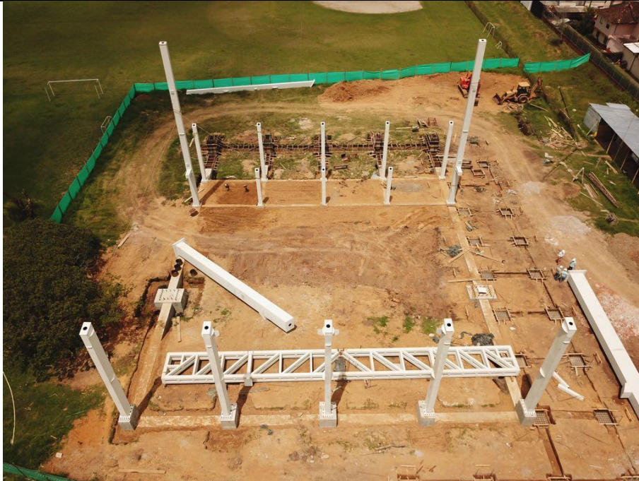
MONTAJE ESTRUCTURA METALICA
