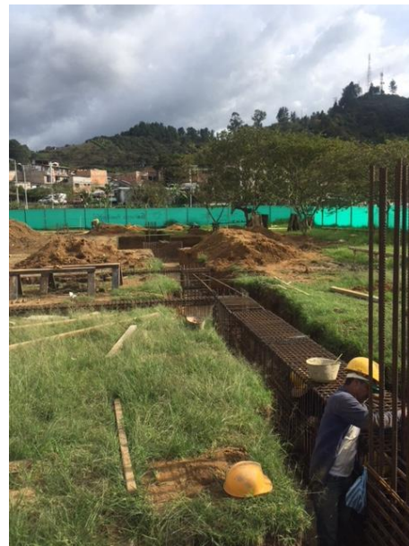
ACERO DE REFUERZO ELEMENTOS ESTRUCTURALES DE CIMENTACIÓN
