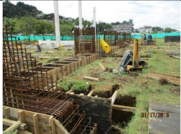
ACERO DE REFUERZO ELEMENTOS ESTRUCTURALES DE CIMENTACIÓN
