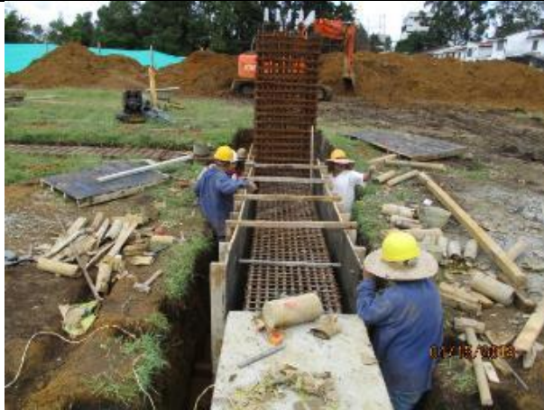
ACERO DE REFUERZO ELEMENTOS ESTRUCTURALES DE CIMENTACIÓN
