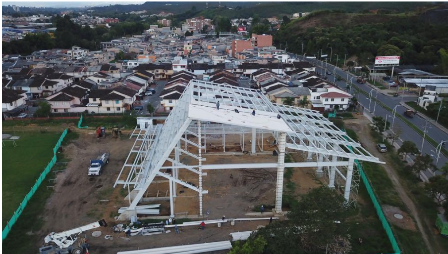
INSTALACIÓN DE CUBIERTA ALUCIN
