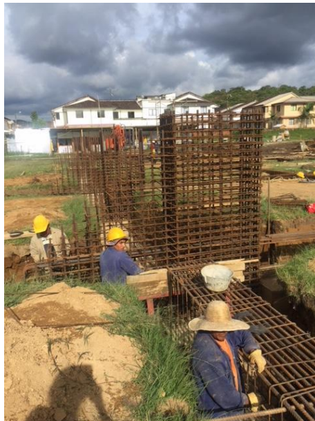
ACERO DE REFUERZO ELEMENTOS ESTRUCTURALES DE CIMENTACIÓN
